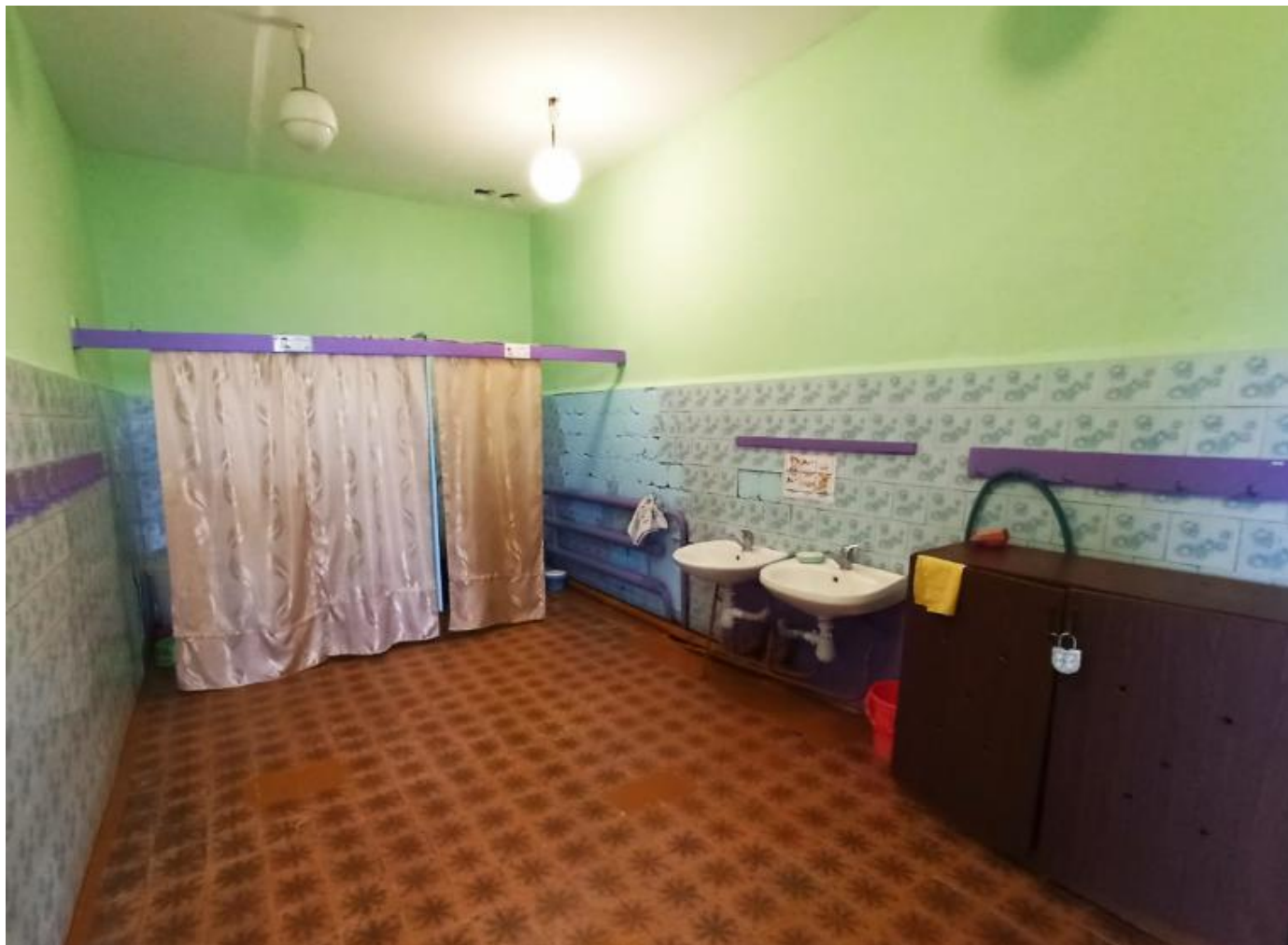
Фото №11 (санитарно-гигиенические помещения)
