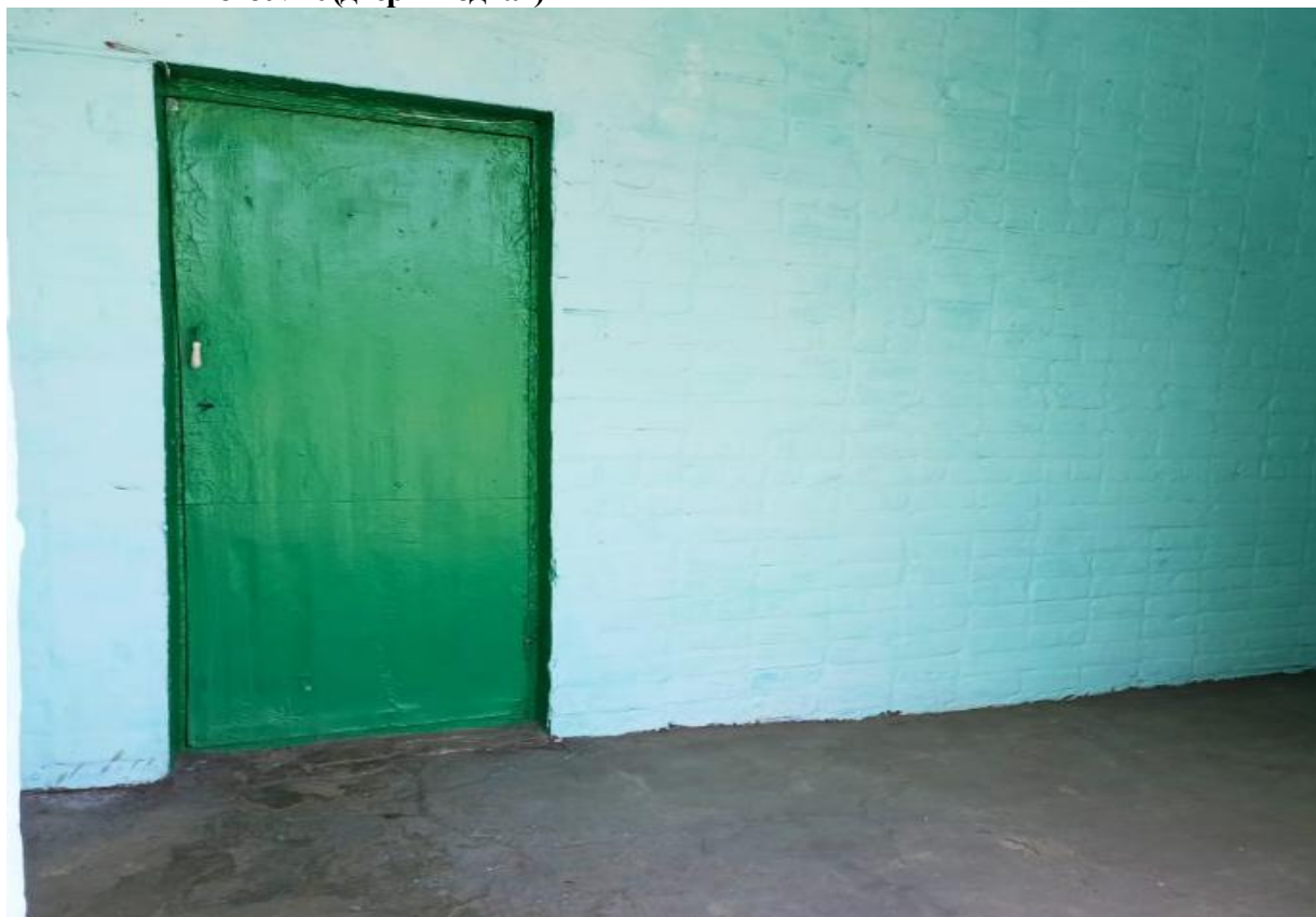
Фото №20 (дверь входная)
