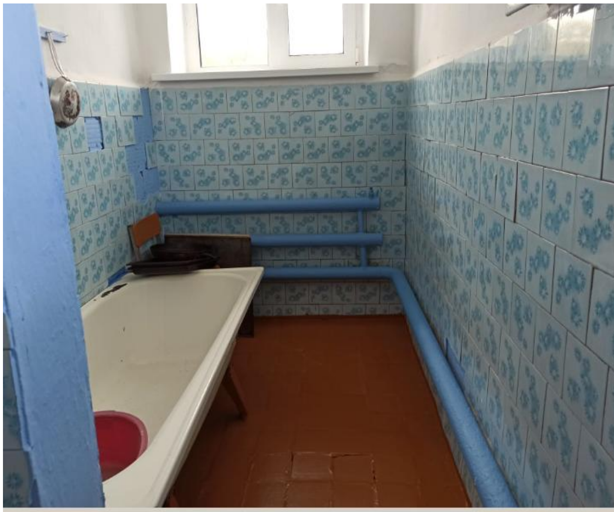
Фото №9 (санитарно-гигиенические помещения)
