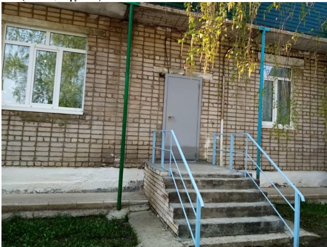
Фото (лестница наружная)
