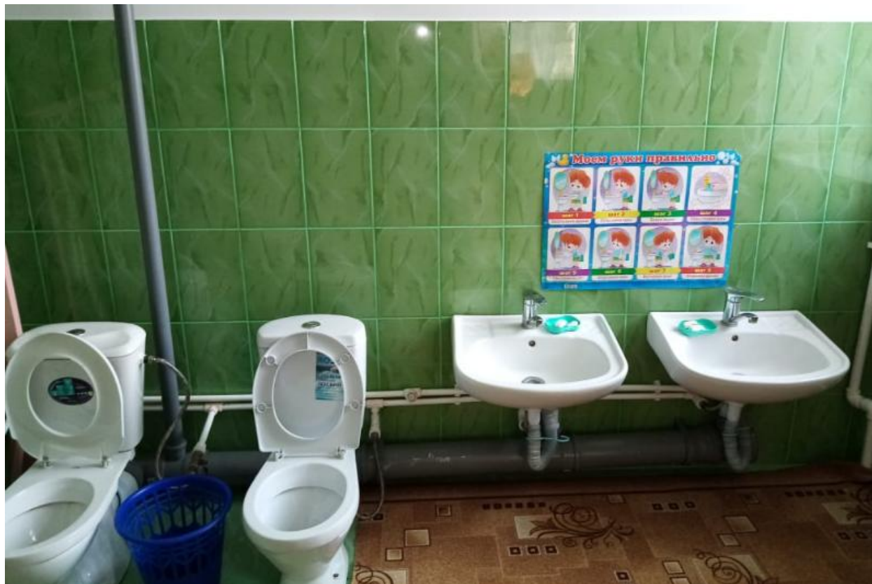
Фото №11 (санитарно-гигиенические помещения)
