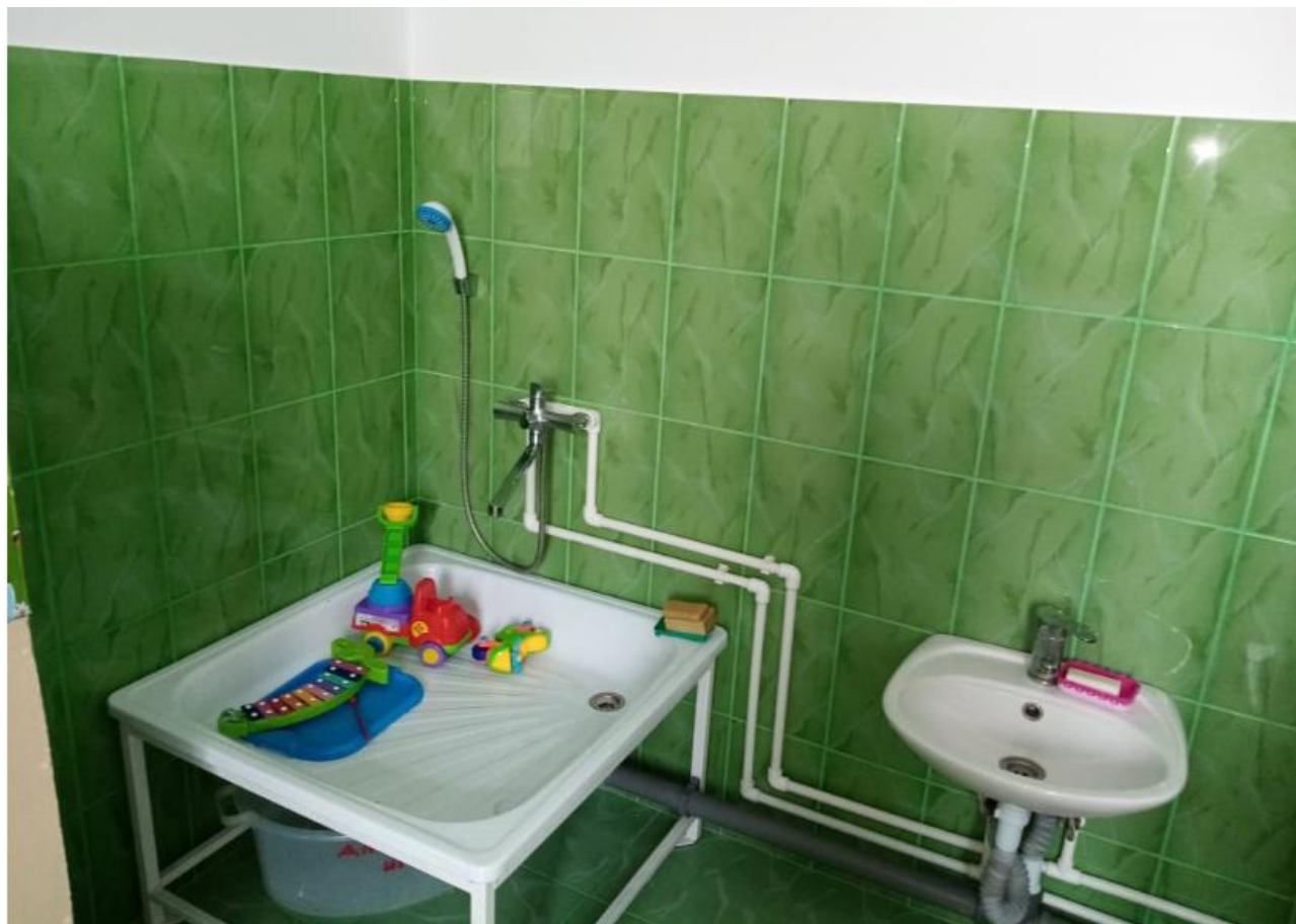
Фото №10 (санитарно-гигиенические помещения)
