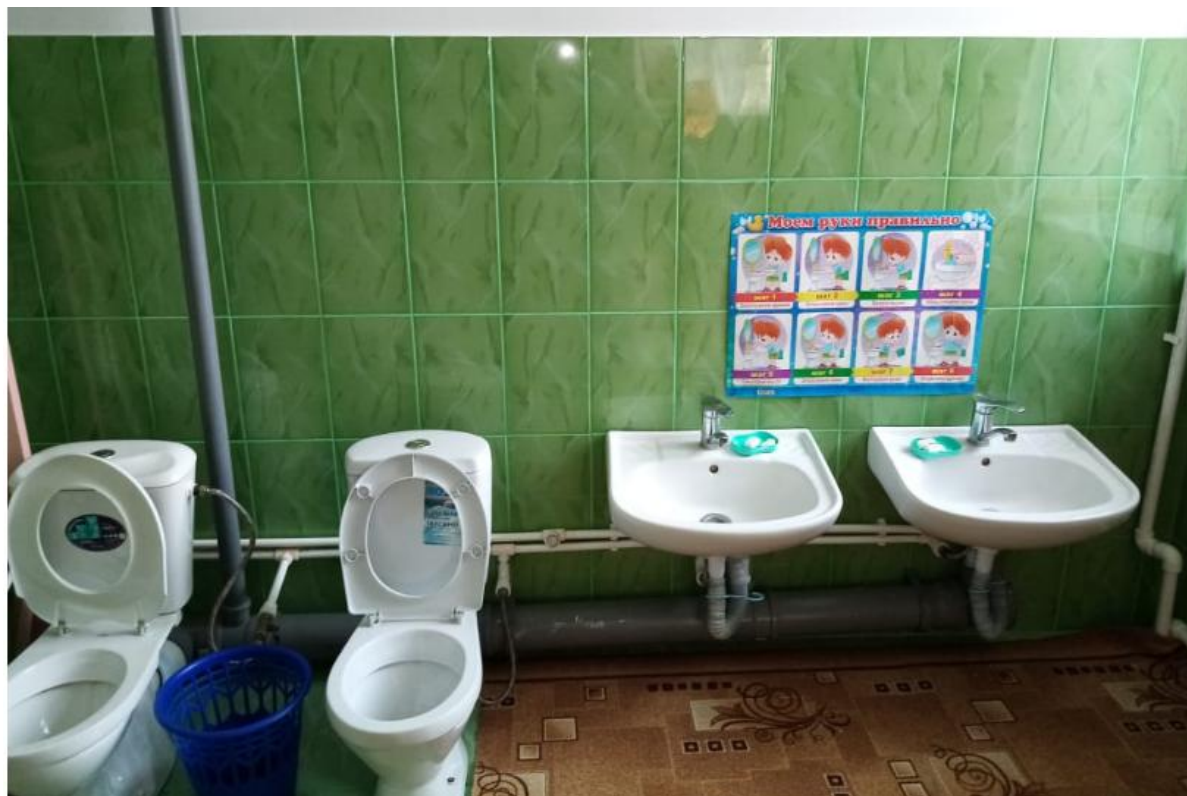
Фото №9 (санитарно-гигиенические помещения)
