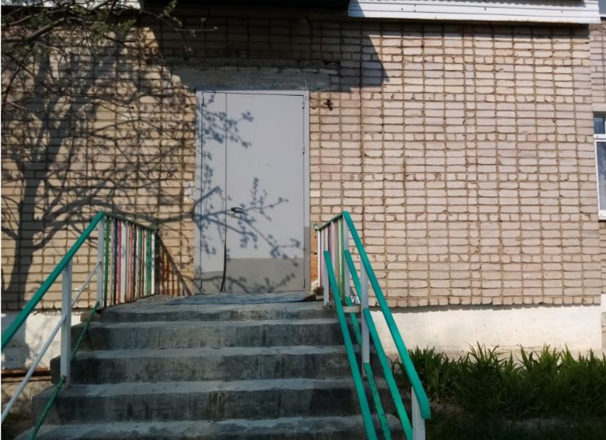
Фото.№20 (дверь входная)
