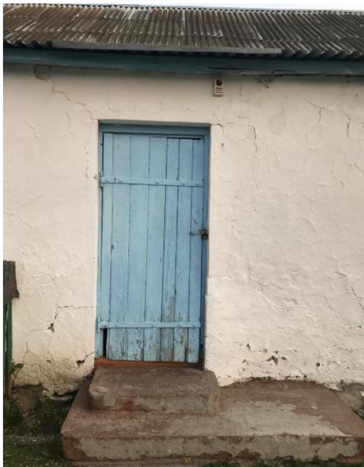
Фото №5 (вход в здание)
