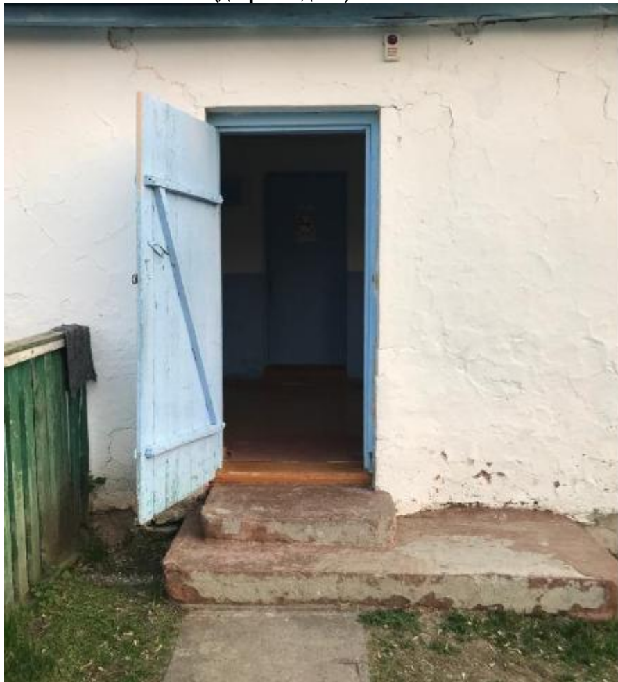
Фото №20 (дверь входная)
