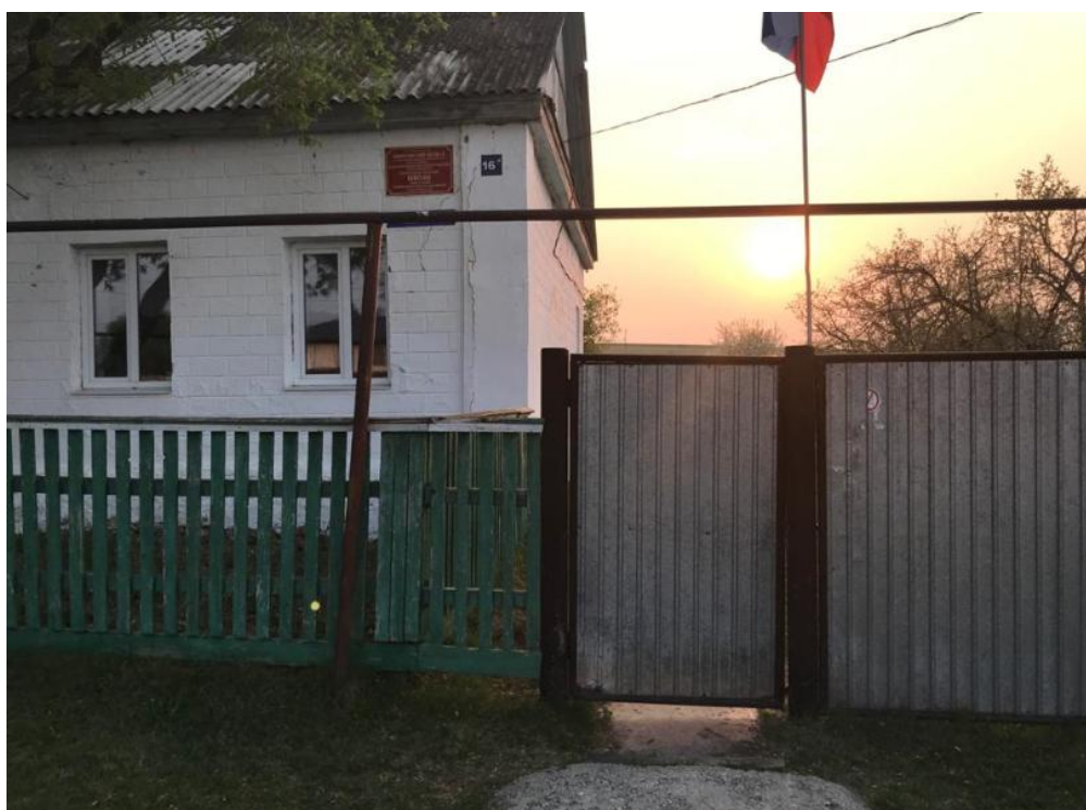
Фото №2 (территория, прилегающая к зданию)
