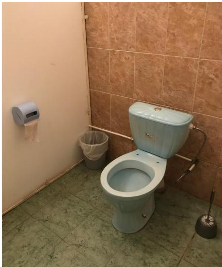
Фото №10 (санитарно-гигиенические помещения)
