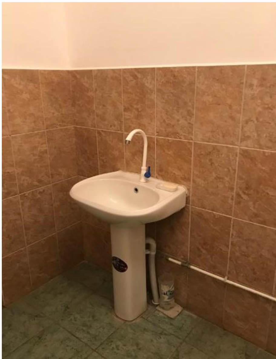
Фото №9 (санитарно-гигиенические помещения)
