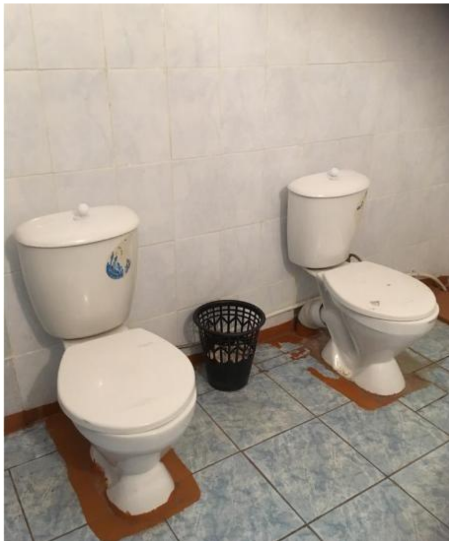
Фото №9 (санитарно-гигиенические помещения)
