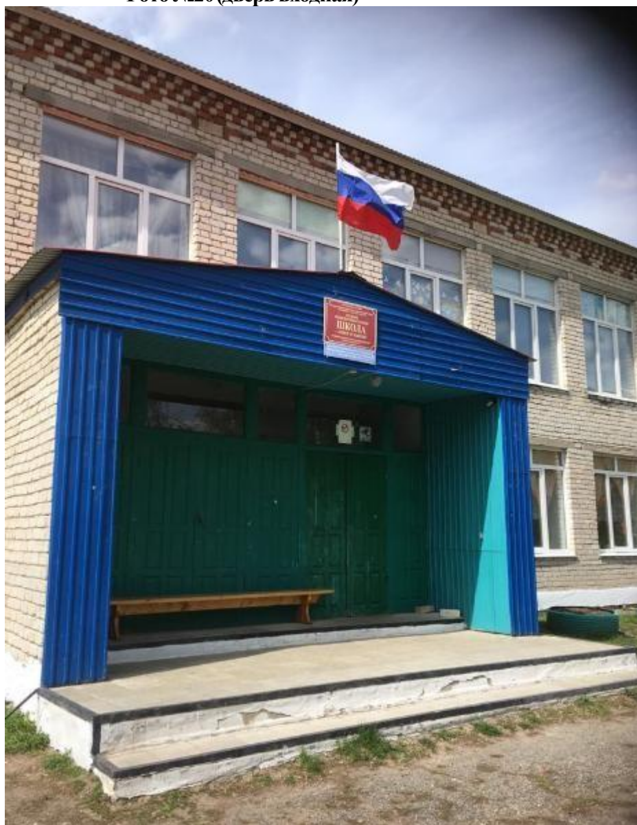
Фото №20 (дверь входная)
