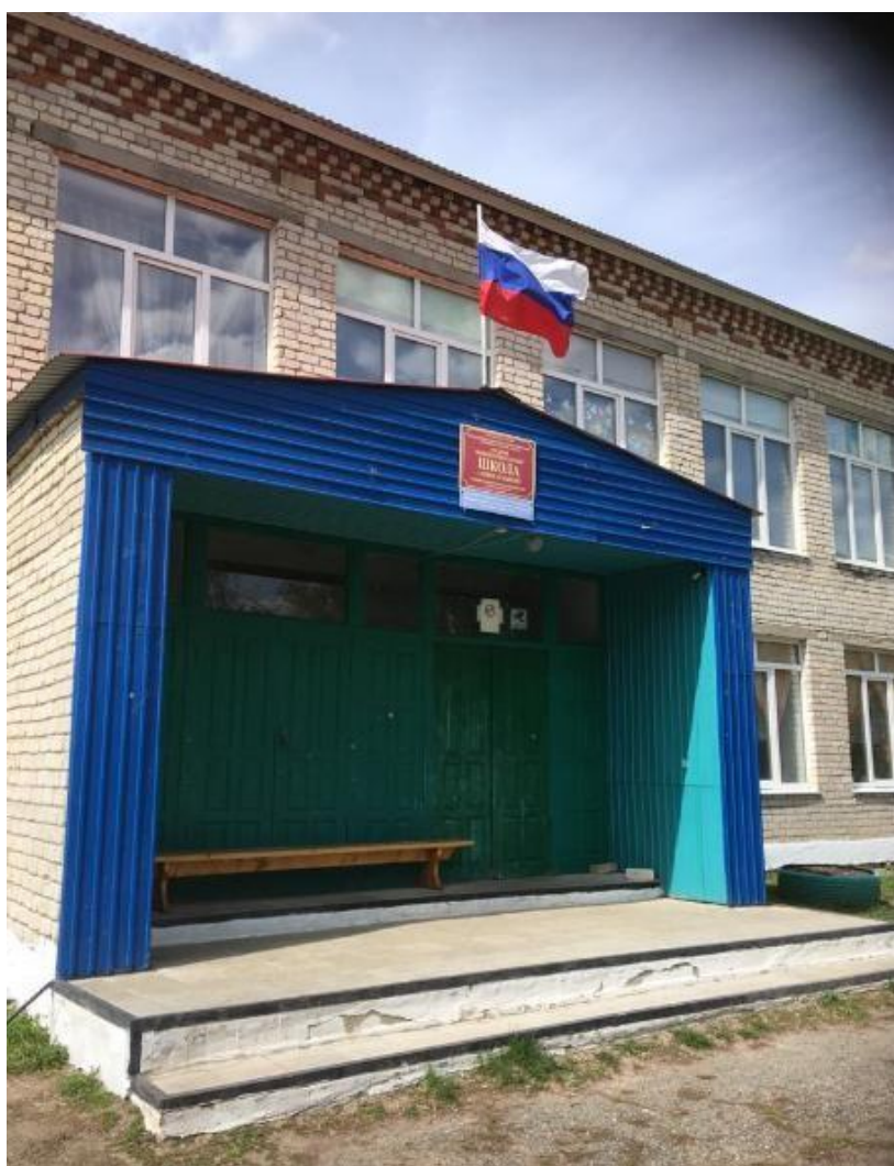
Фото №5(вход в здание)
