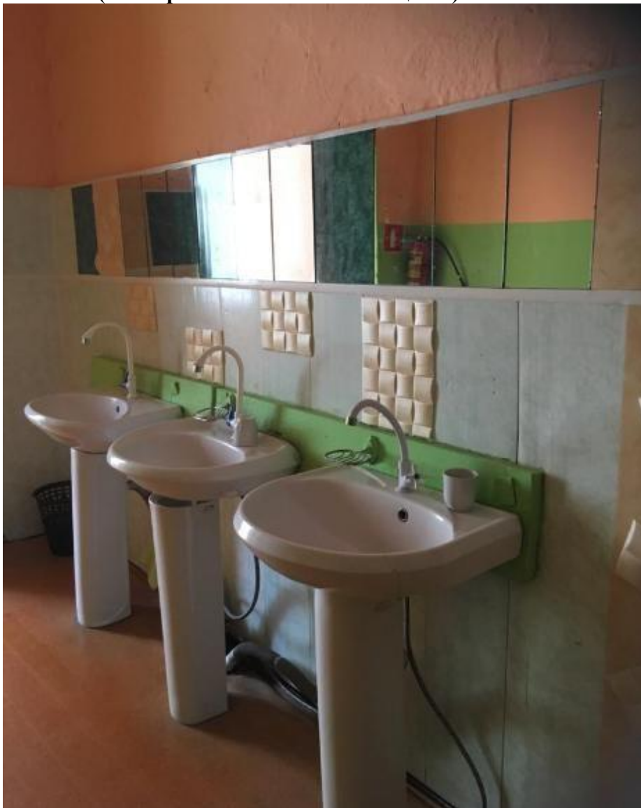
Фото №11 (санитарно-гигиенические помещения)
